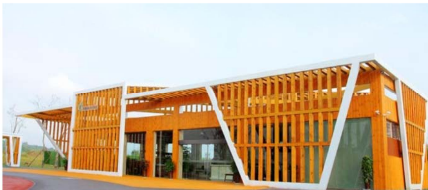
图 3-24 高架自行车道途中驿站
