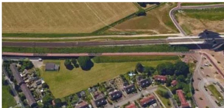
图 2-5 通过将近 600 米的下坡，连接到地面
