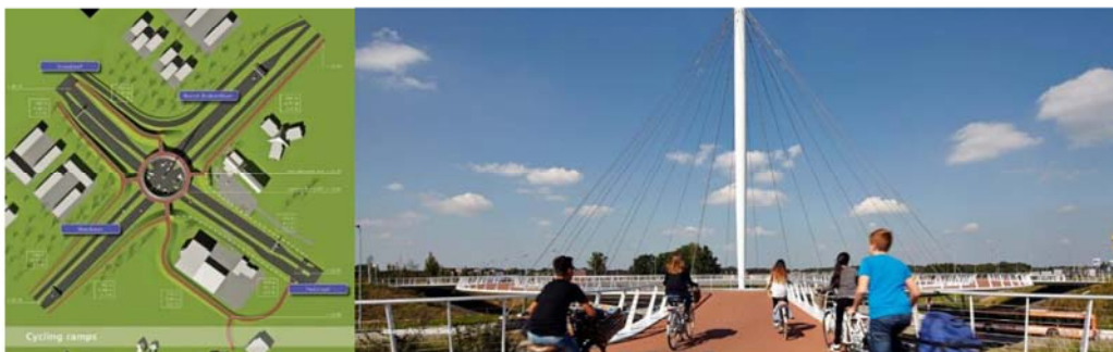
图 3-7 荷兰 Hovenring 高架自行车道
