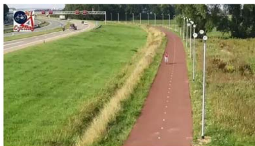
图 3-6 荷兰 F325 高速路实景图
