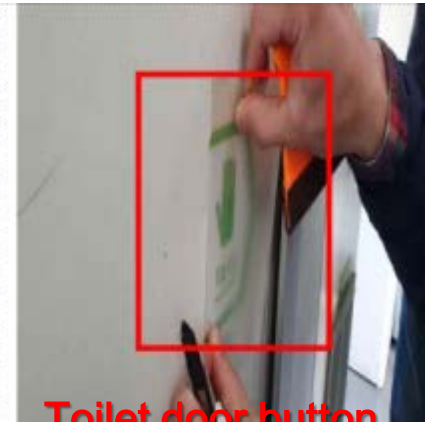
Toilet door button
