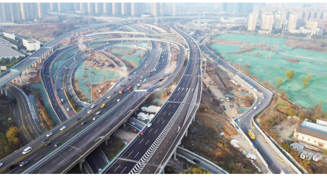
南京加快建设高质量综合立体交通网络。 本文图片由 南京市交通运输局 提供
